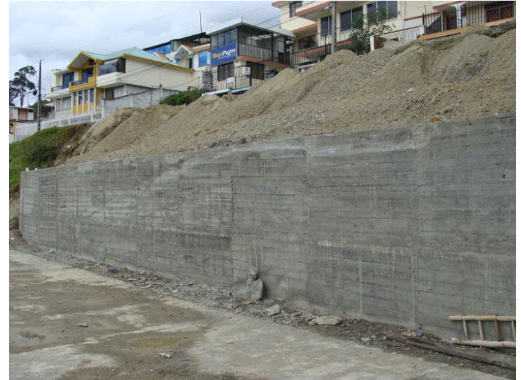
Muro de sostenimiento en el barrio Las Américas
