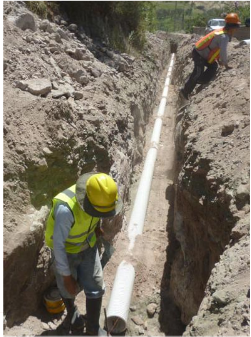
Alcantarillado sanitario La Palmira, Quinara
