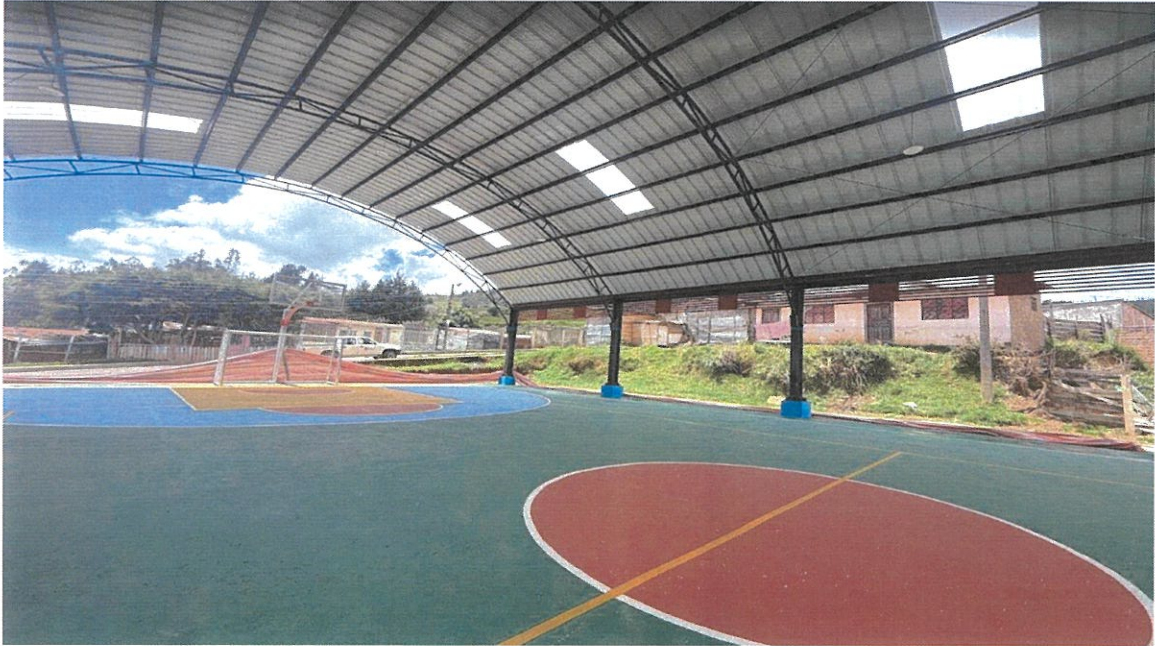
Cubierta del Barrio Víctor Emilio Valdivieso
