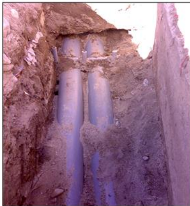
CANALIZACIÓN DE 2 VÍAS (TUBERÍA PVC SOBRE CAMA DE ARENA CON SUS RESPECTIVOS SEPARADORES)
