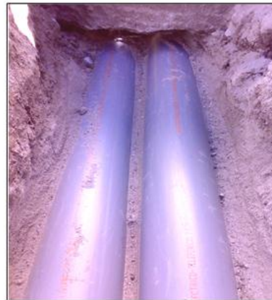
CANALIZACIÓN DE 2 VÍAS (TUBERÍA PVC SOBRE CAMA DE ARENA CON SUS RESPECTIVOS SEPARADORES)
