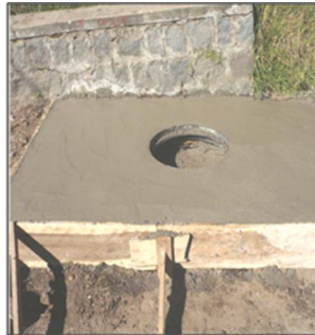
Pozo Terminado En Acera
