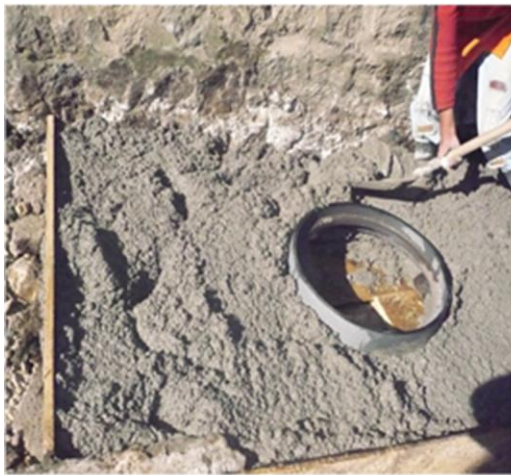
Fundición De Pozo En Acera
