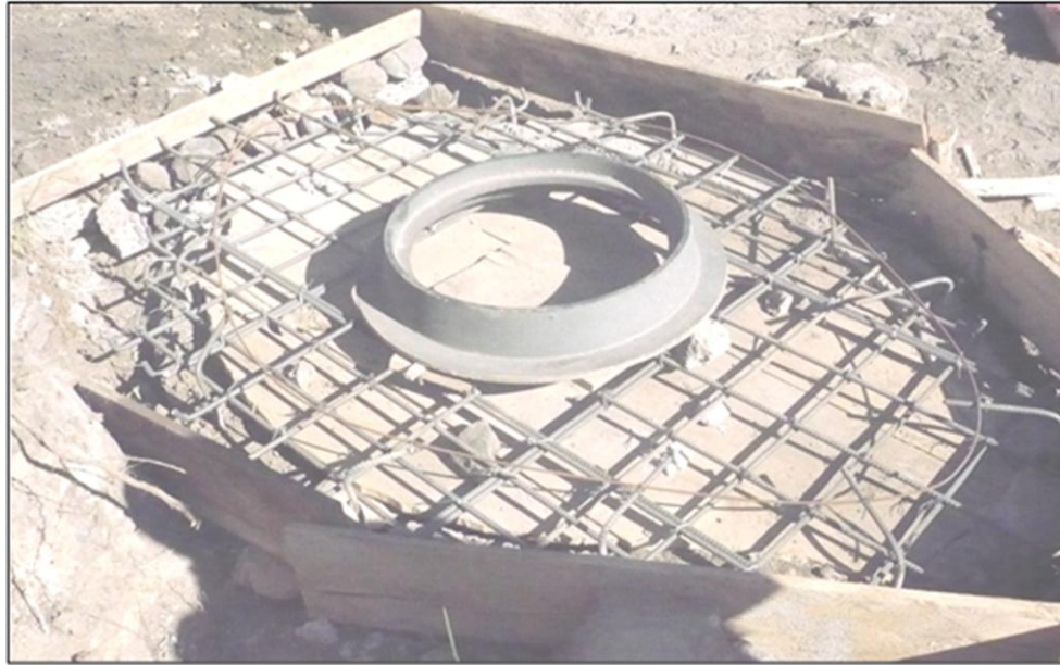
Armadura de losa del pozo
